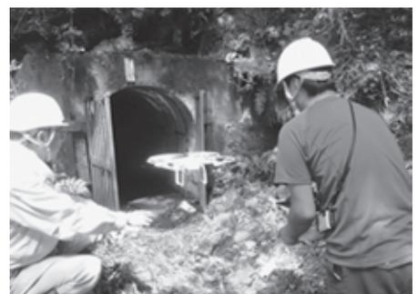
写真-3 (排水トンネル工点検状況)
