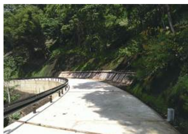
林道工事：日和茶坂瀬線
